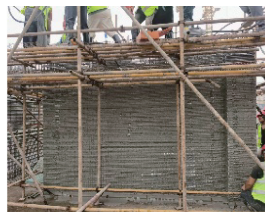
图 3 剪力墙浇筑后
