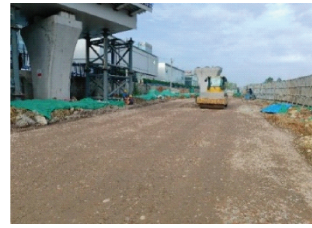
图5 再生材料路基施工效果
