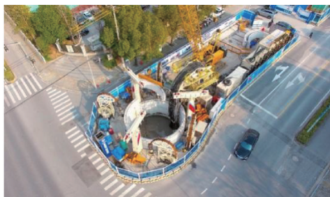
图 12 工作井机械法沉井施工
