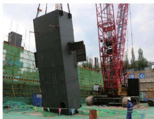
图 1 多腔巨柱安装
