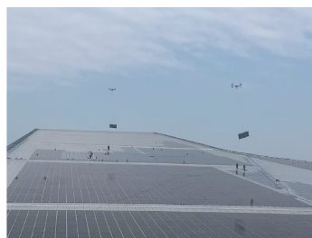
图11 光伏组件无人机转运
