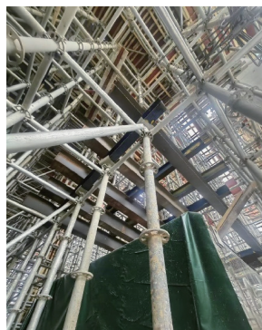
图 12 支撑体系现场搭设
