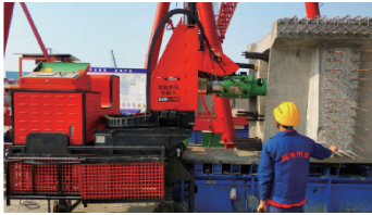
图 10 自行式智能张拉机器人
