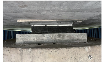
图6 施工完成后支座
