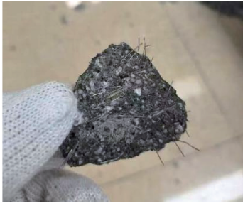
图6 UHPC局部侵蚀情况
