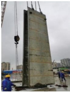
图 6 预制地下连续墙吊装过程
