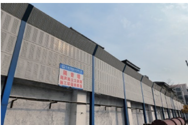
图 2 施工场地隔声屏障
