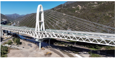
图 12 成桥效果 Fig. 12 Bridge effect
