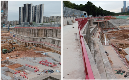
图 11 阶梯型 4 排桩现场
