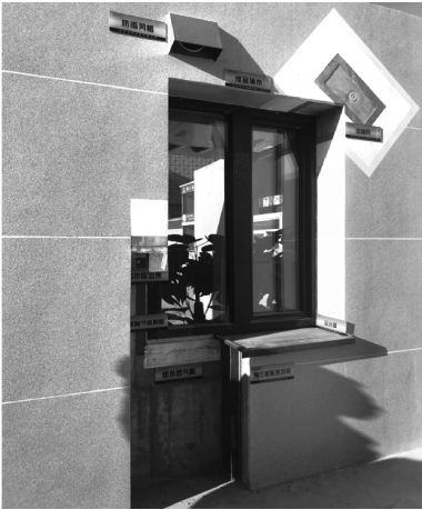
图4 外窗安装节点模型
