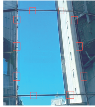
图 3 标准玻璃面板连接示意
