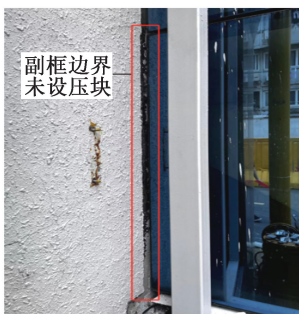
图 8 异常玻璃面板连接情况现场检查
