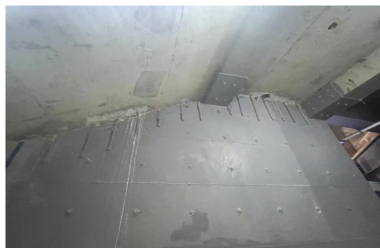
图6 等代钢筋与钢板条连接示意
